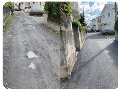
道路整備「舗装工事」
